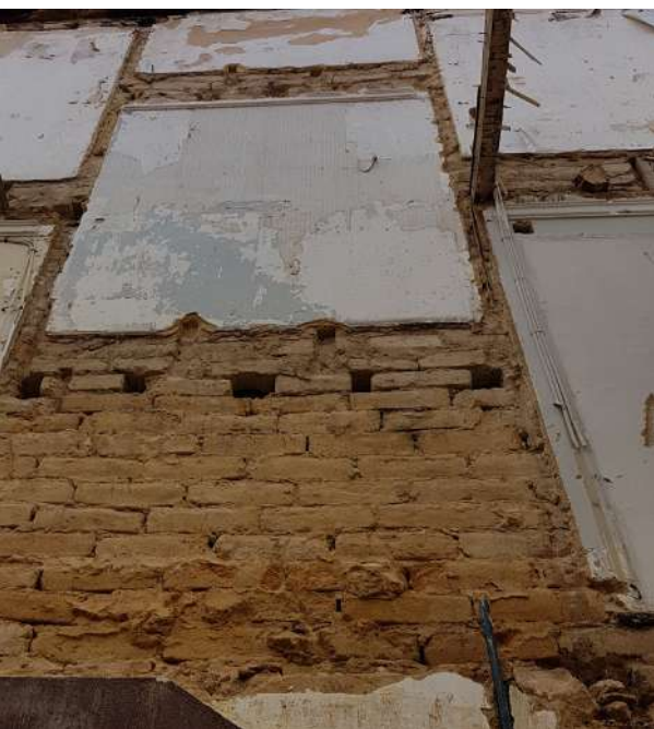
Figura 3 – Parede meeira de adobe. Fonte: Foto de Alice Tavares.
