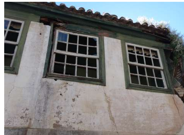
Figura 5 – Estrutura de gaioleiro sobre estrutura de pedra, Castelo Mendo. Fonte: Foto de Alice Tavares.
