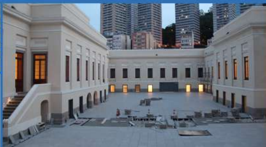
INSTALAÇÃO DE PISO ELEVADO PARA DRENAGEM E FÁCIL MANUTENÇÃO INSTALLATION OF ELEVATED FLOORING FOR DRAINAGE AND MAINTENANCE
