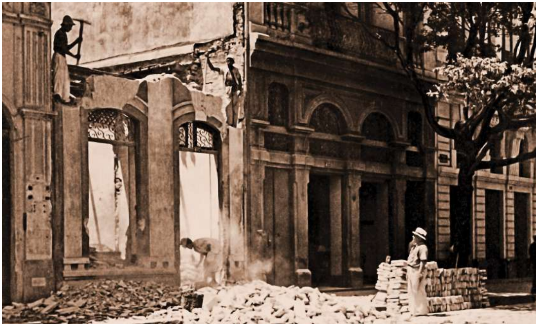
Figura 3 – Demolição de sobrado, Recife, Pernambuco, Brasil. Foto de Benício Whatley Dias, 1940. Acervo Cehibra, Fundaj, Ministério da Educação.
