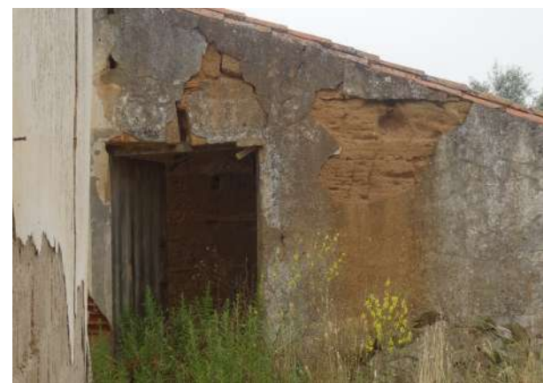
Figura 6 – Construção em taipa. Fonte: Foto de Alice Tavares.
