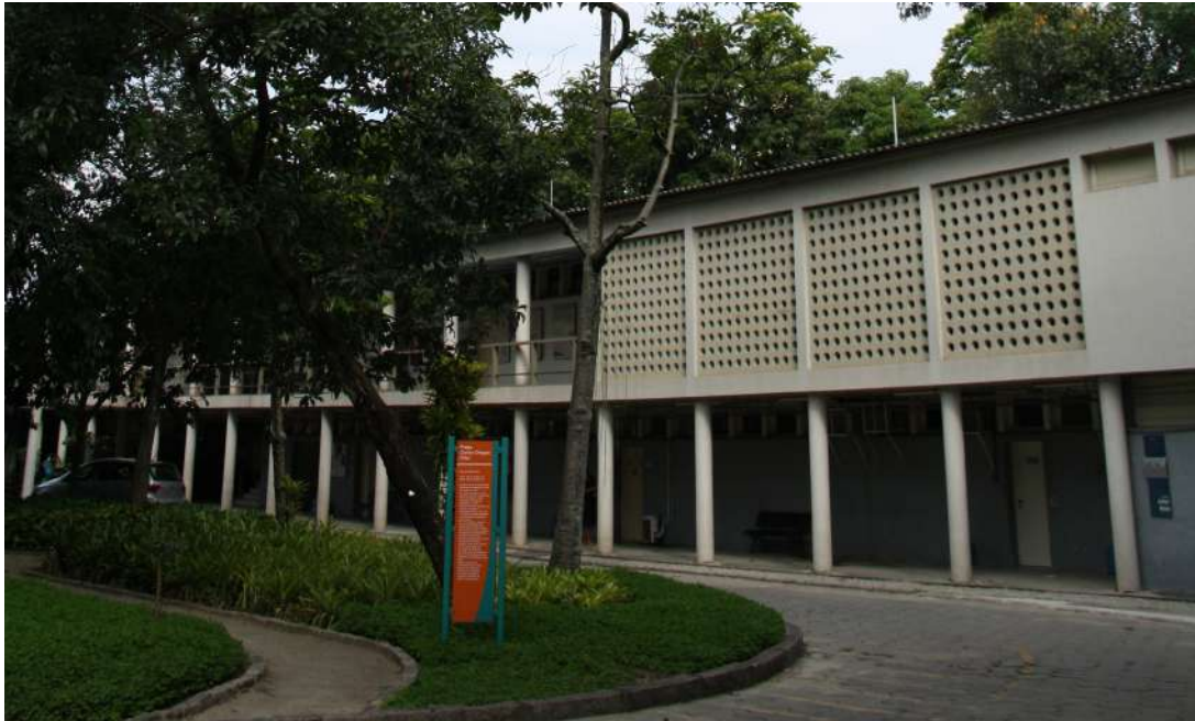
Figura 4 – Fechamento com cobogós no corredor avarandado do segundo pavimento, na fachada nordeste. Fonte: DPH/COC/Acervo da Fiocruz, 2013.
