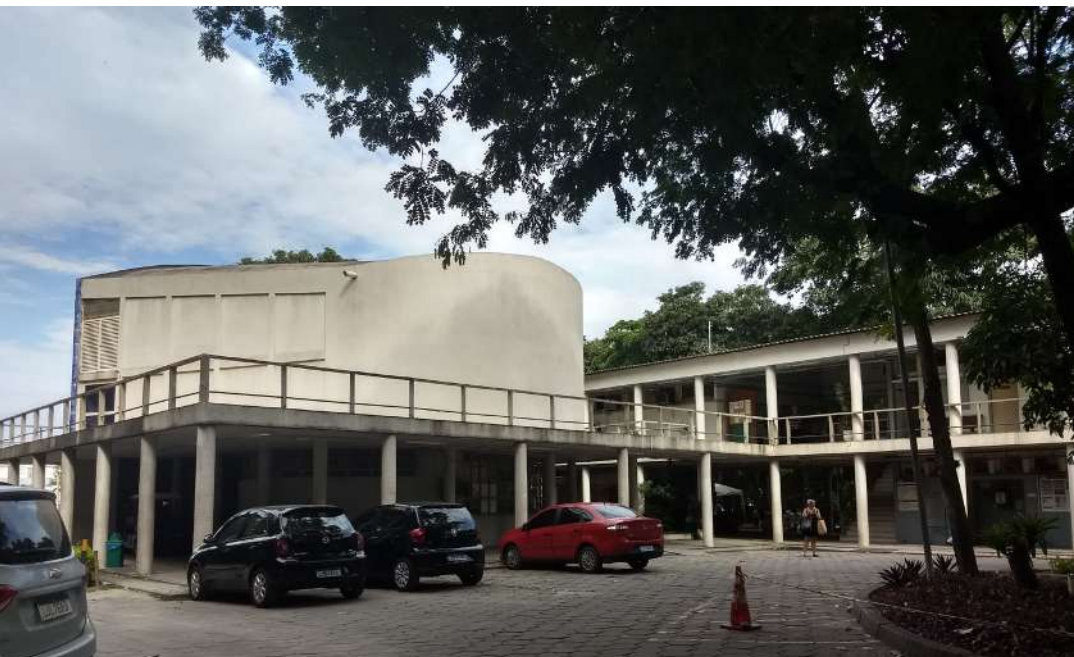
Figura 3 – Bloco do auditório com a demarcação das janelas preexistentes, no segundo andar. À frente delas havia brise-soleils , que foram demolidos. Fonte: DPH/COC/Acervo da Fiocruz, 2013.
