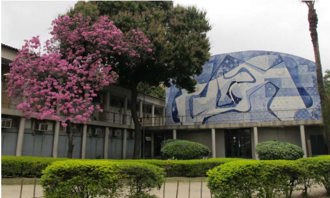
Figura 2 – Vista do pavilhão a partir da Avenida Brasil. À esquerda, no primeiro pavimento, pode-se ver o primeiro andar ocupado por um acréscimo, onde antes havia a varanda e o pilotis. Foto de Glauber Gonçalves, 2016.
