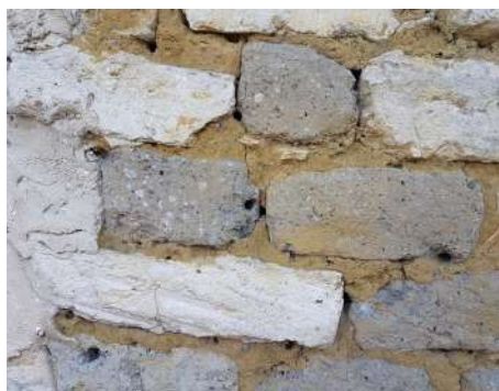
Figura 8 – Parede com adobe de cal e adobe de terra, Aveiro. Fonte: Foto de Alice Tavares.
