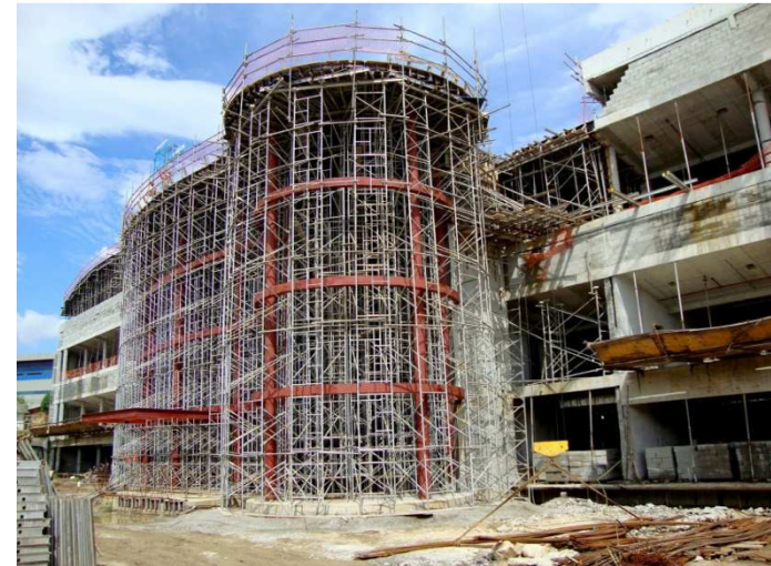
Imagem 10: Fotografia da construção do CDTs. Vista da Fachada Norte da Edificação Principal. Fonte: Acervo do autor (2010).
