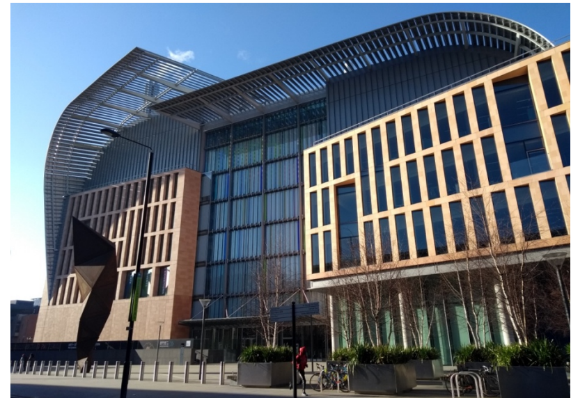
Imagem 7: Proteções contra radiação solar usadas para definir a forma do edifício. Francis Crick Institute, Londres, Inglaterra. Fonte: acervo do autor (2018).
