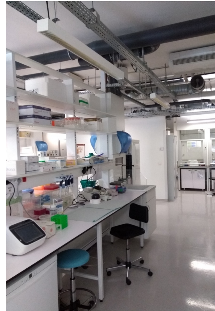
Imagem 5: Laboratórios com tubulações aparentes – sistemas independentes e visíveis. Edifício François Jacob, Instituto Pasteur, Paris, França. Fonte: acervo do autor (2018).
