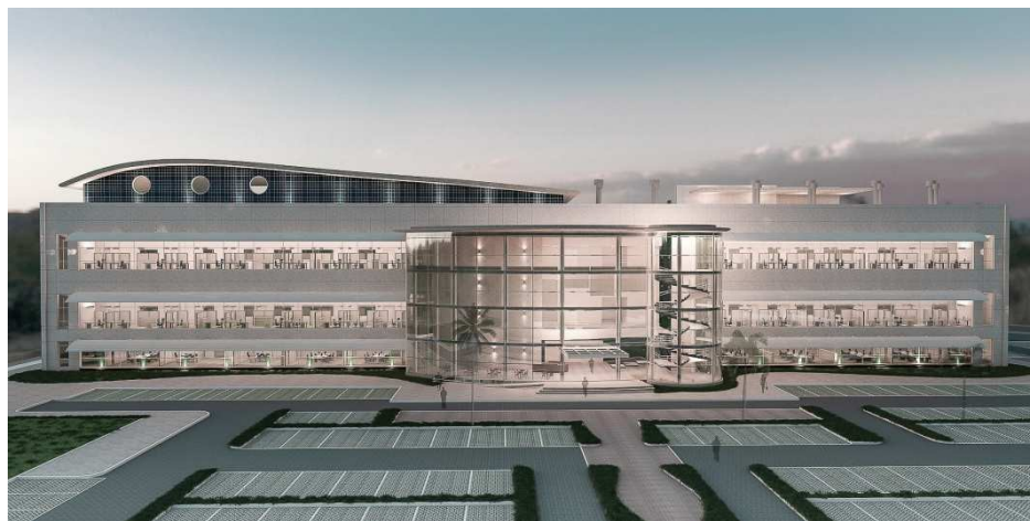
Imagem 16: CDTS. Maquete virtual. Vista da Edificação Principal. Fonte: Acervo PAAL (2019).
