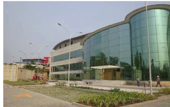
Imagem 11: Fotografia atual da Edificação Principal do CDTs. Vista da Fachada Norte da Edificação Animal. Fonte: Acervo do autor (2019).
